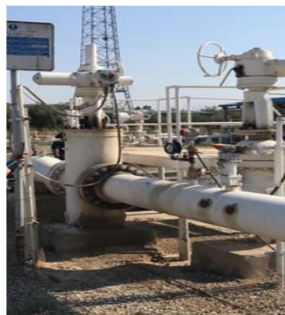
شکل ۴: نمایی از ارسال کننده پیگ در ایستگاه ارسال خط ۱۴ اینچ فرآورده (پیگ رانی شماره ۱)
