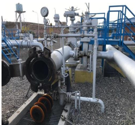
شکل ۶: نمایی از دریافت کننده پیگ در ایستگاه خط ۱۴ اینچ فرآورده (پیگریانی شماره ۳)
