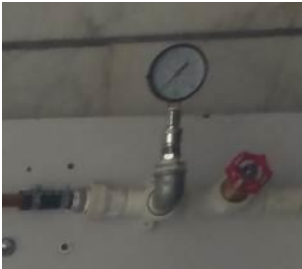
شکل ۱ نحوه اتصال فشارسنج به مدار
