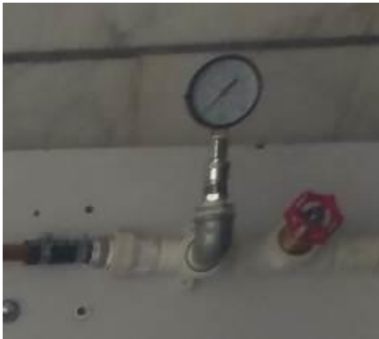
شکل ۱ نحوه اتصال فشارسنج به مدار
