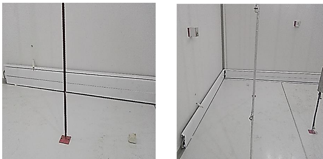
شکل ۵- رادیاتور های قرنیزی نصب شده در اتاق استاندارد حین انجام آزمون
