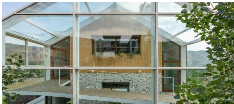
شکل ۱۱: دیوار ترومب در ویلاي دشت چهل [۳۳]
