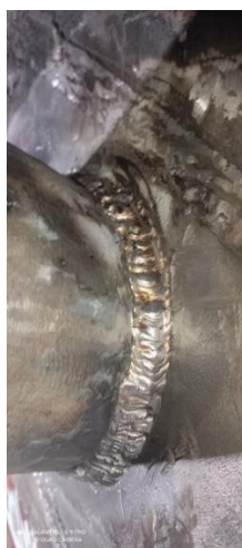
شکل ۶: نحوه اتصال یکی از لوله‌های سیستم هوادهی با کمک جوشکاری
