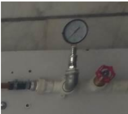
شکل ۱ نحوه اتصال فشارسنج به مدار
