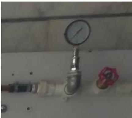
شکل ۱ نحوه اتصال فشارسنج به مدار
