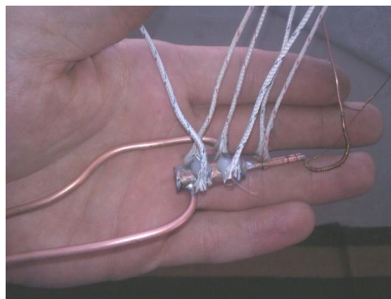
شکل ۷- محل قرارگیری و نصب ترموکوپل ها
