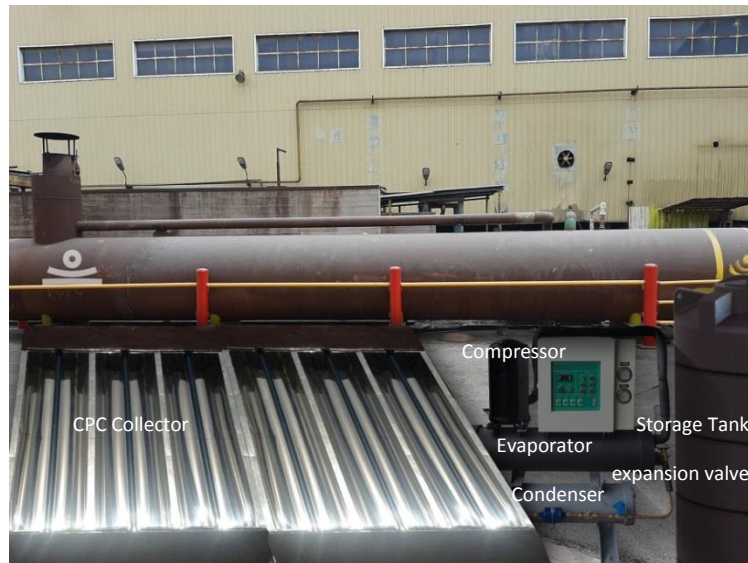
شکل ۱: کلکتور خورشیدی سهموی مرکب متصل به پمپ حرارتی
