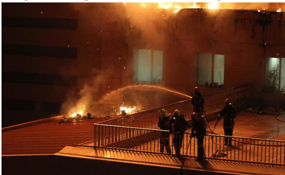
شکل ۱- ریزش قطعات مشتعل نمای برج سلمان بر بام ساختمان‌های مجاور [۲]
