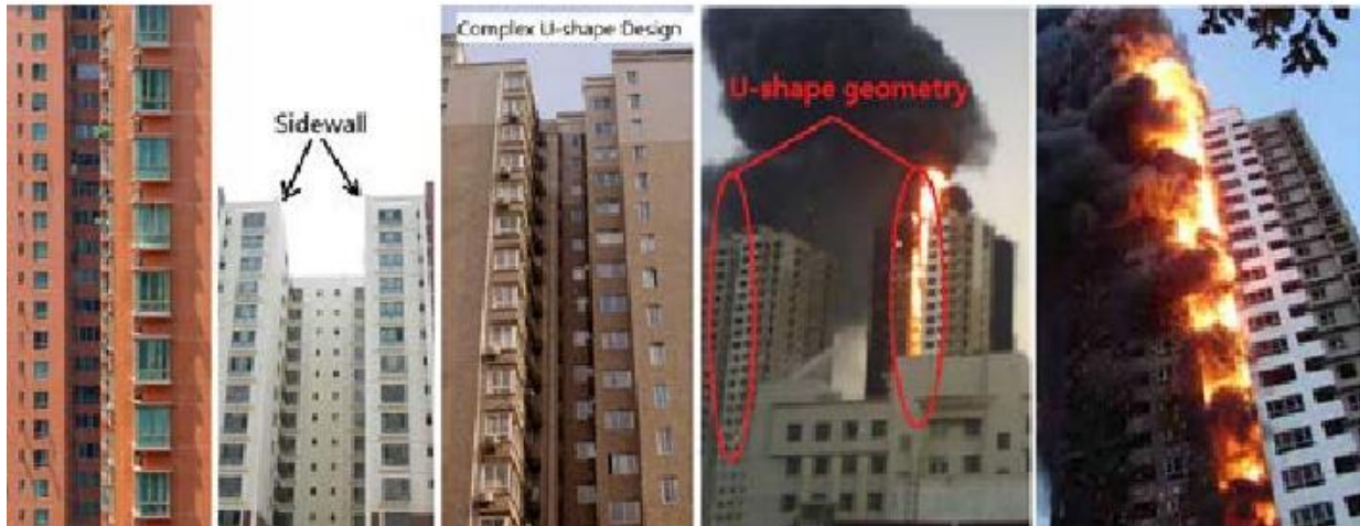
شکل ۶- نمای U شکل و آتش سوزی، شانگهای، چین، [۱۸]
