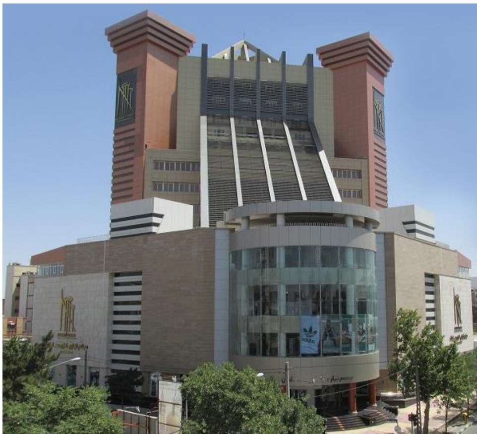
شکل ۷- فرم شیب دار و U شکل در برج سلمان و پدیده دودکش [۱۹]
